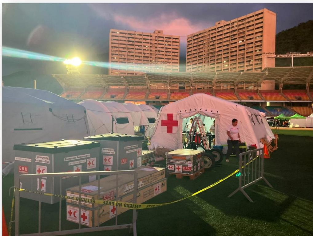
Instalación y montaje de la clínica de emergencia de Cruz Roja Española en la Guaira
