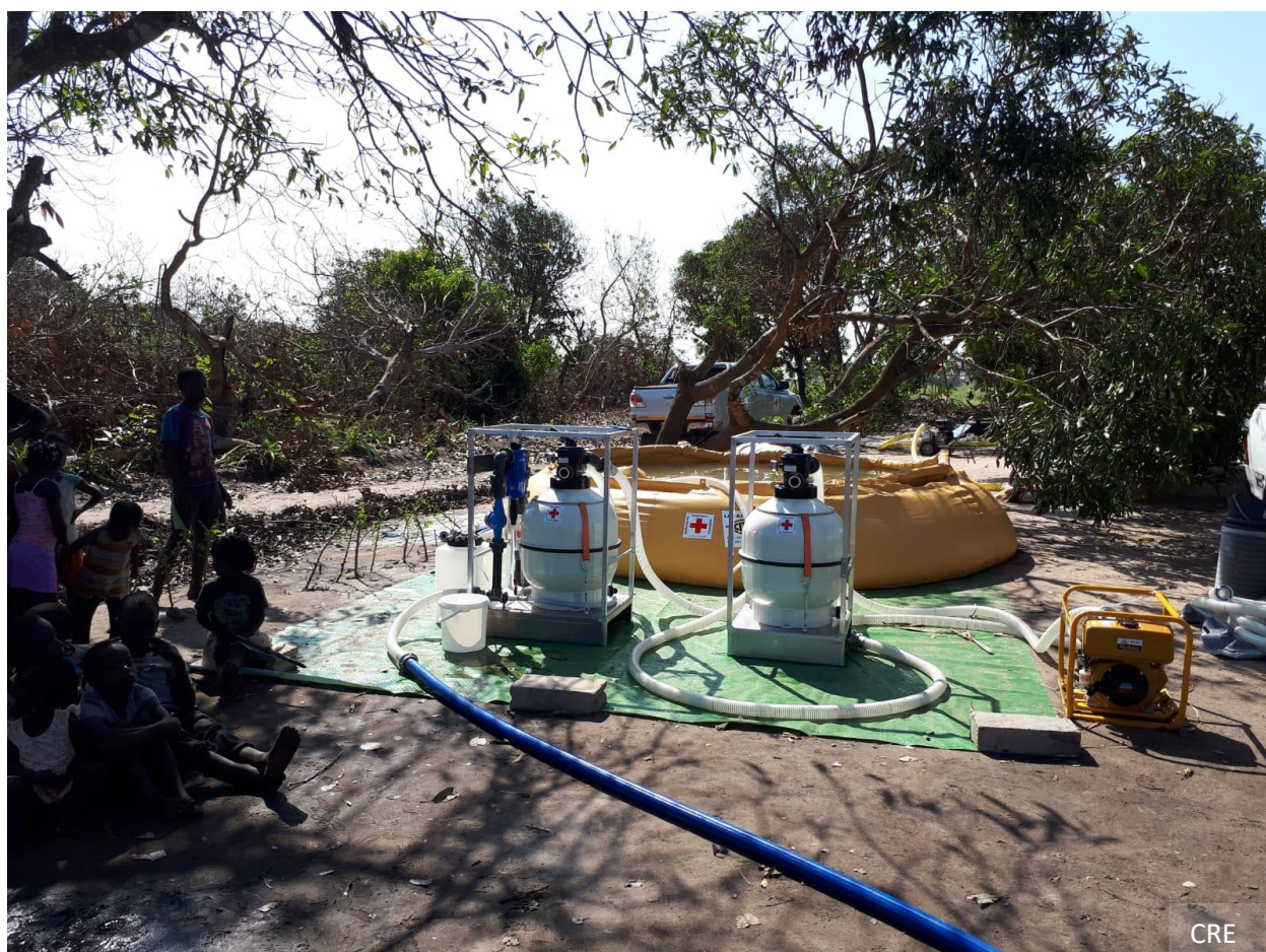
Instalación de punto de agua
