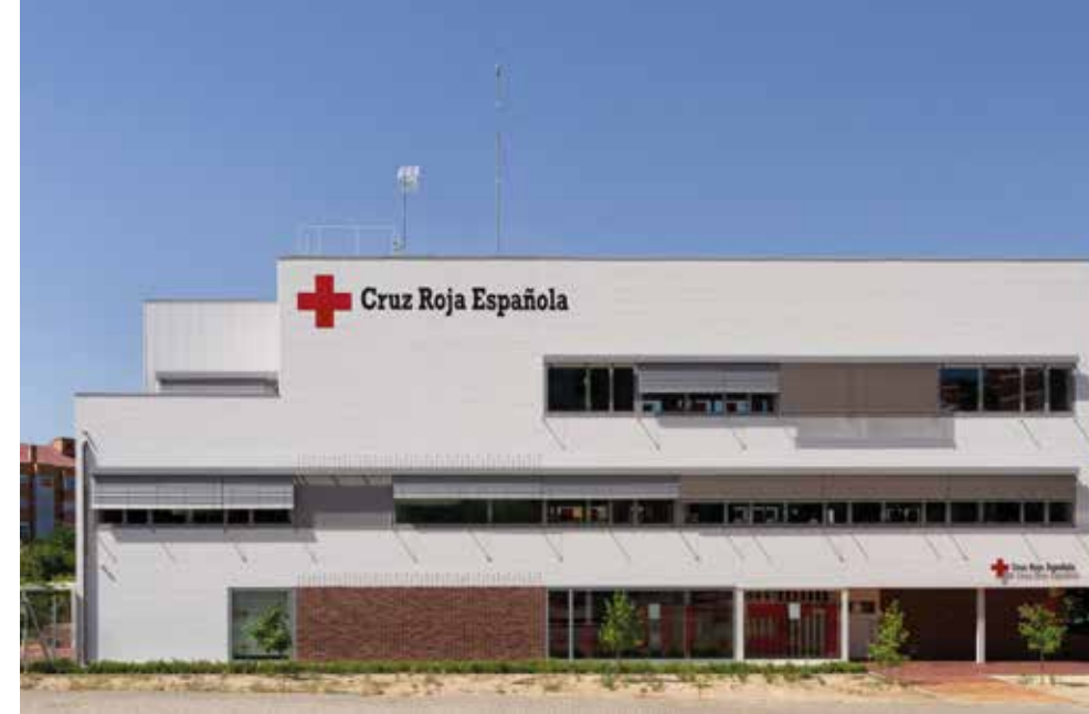
La seu de Creu Roja a Alcorcón està construïda amb termoargila i compta amb la màxima qualificació energètica
