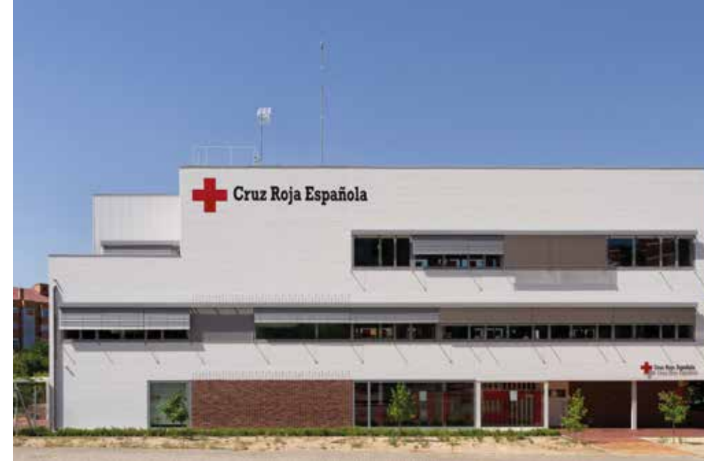
La seu de Creu Roja a Alcorcón està construïda amb termoargila i compta amb la màxima qualificació energètica
